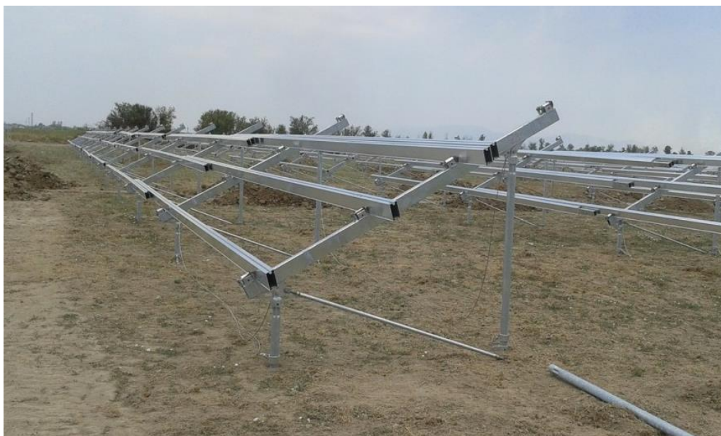
Figura 5 : Sistem de cadru mono-rail aluminiu cu piloni înșurubați – dedicat sistemelor fotovoltaice terestre. Sursa: Krinner Solar
